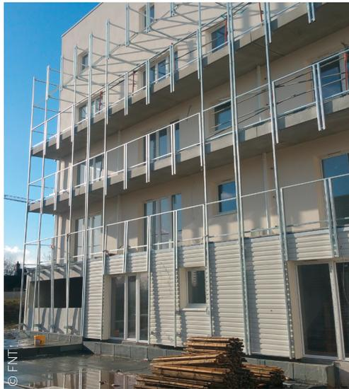
Pose de la structure tubulaire avant la fixation des ganivelles.
